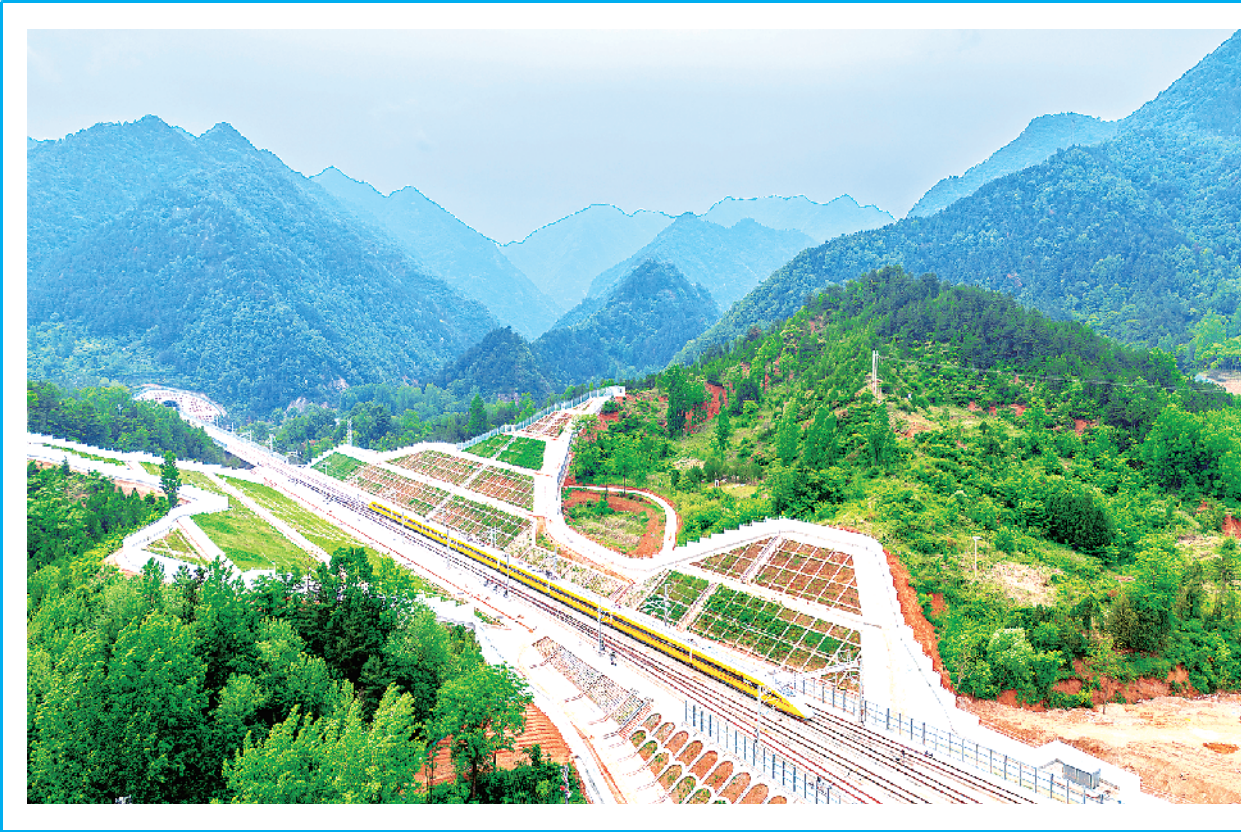
5月12日,DJ602次综合检测列车行驶在陕西省山阳县境内(无人机照片)。
