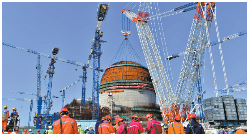
中核集团福清核电6号机组反应堆穹顶吊装成功
