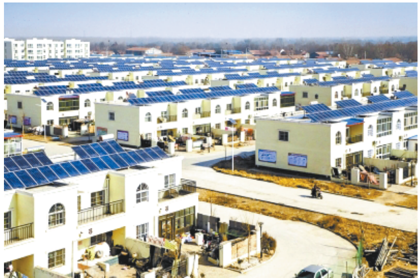
范县张庄乡黄河滩区居民迁建安置点千安社区一排排整齐漂亮的新房。
