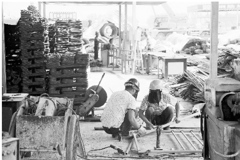
工人正在进行焊接作业
