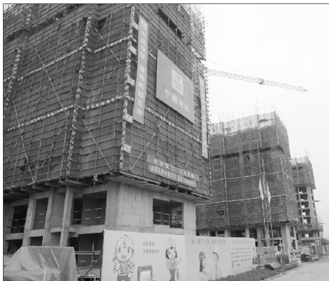
4栋高层正在进行主体施工
