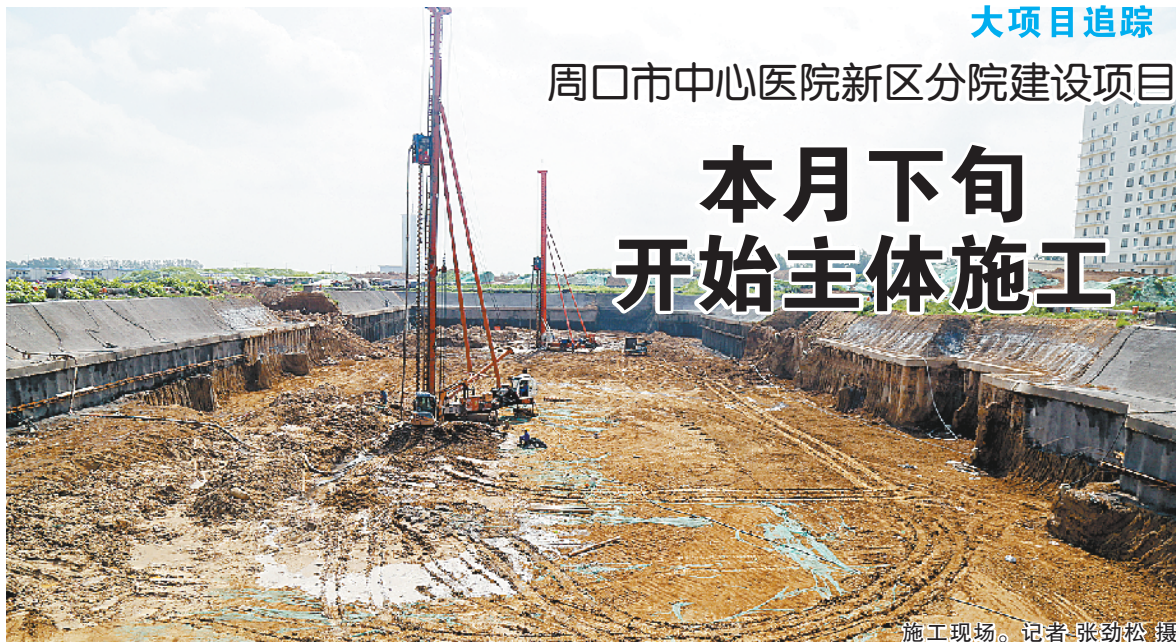
施工现场。记者 张劲松 摄
