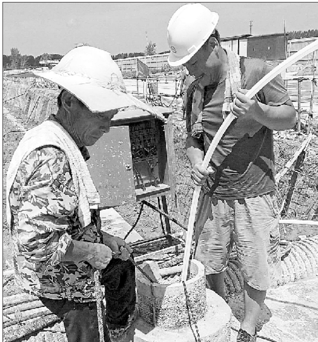
贾鲁嘉苑项目 L 地块施工现场,建筑工人正在对降水井进行抽水
