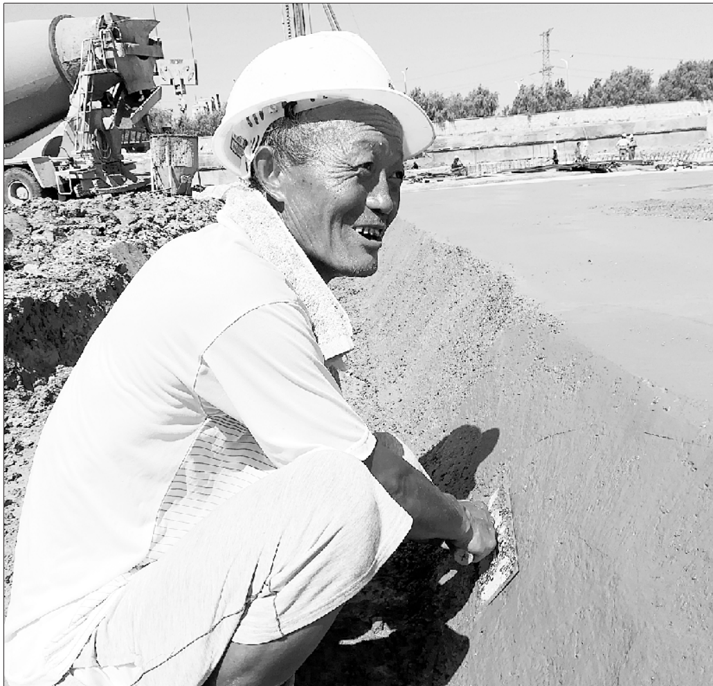
泰和家园项目施工现场,建筑工人正在做地库垫层
