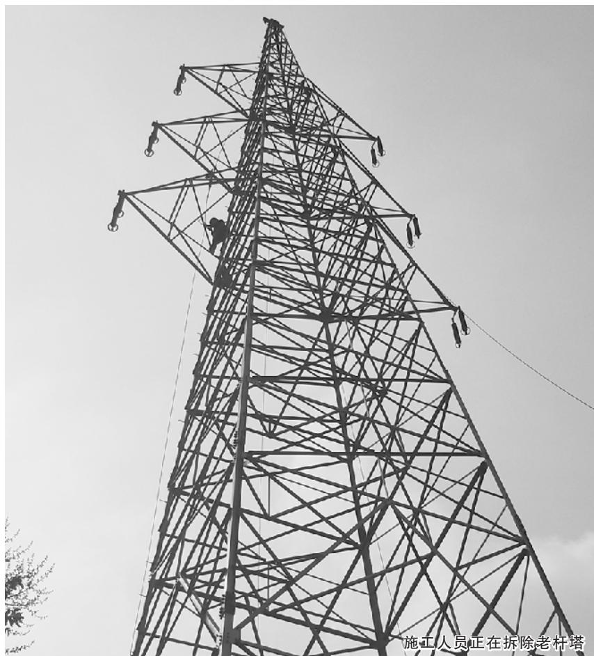
施工人员正在拆除老杆塔
