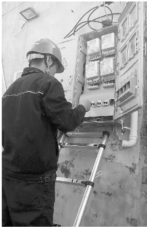
周口供电公司工作人员正在核查电能计量装置是否被人为改动。
