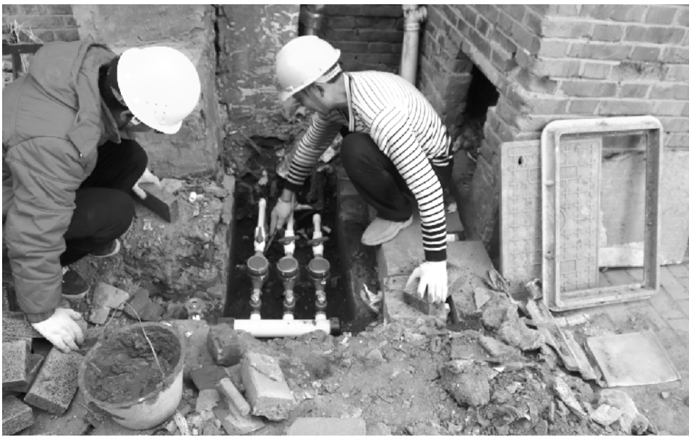
施工人员对老旧管材进行更换
