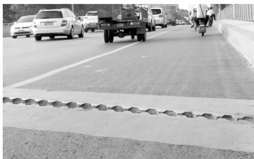
周口市中心城区沙颍河周口大道桥一处桥面钢板衔接错位,“张口”吓人。昨日,记者在该桥东侧桥面上看到,有两段上下咬合、用来衔接桥板缝隙的钢板明显错位,形成不同程度的开口,最大开口约5厘米宽,加之上下两条钢板都有“牙齿”,很是吓人。车辆和行人路经此处时,大都绕道而行。希望有关部门尽快修复此处桥面,及早消除安全隐患。
