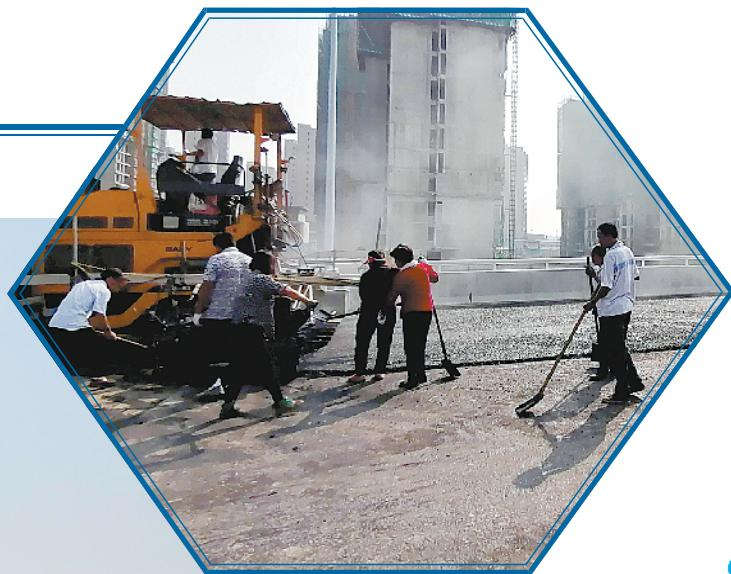
周商连接通道八一大道打通工程是我市第一批百城建设提质工程，工地上跨漯阜铁路和洛宁高速，全长1735米，中间高架桥长1400多米，道路双向6车道，路面宽35.5米。目前，路灯、护栏已经安装到位，路面铺设接近尾声，道路中间隔离带已经设立，工人们正在加紧施工桥梁连接线。预计，该工程国庆节前就能通车。
