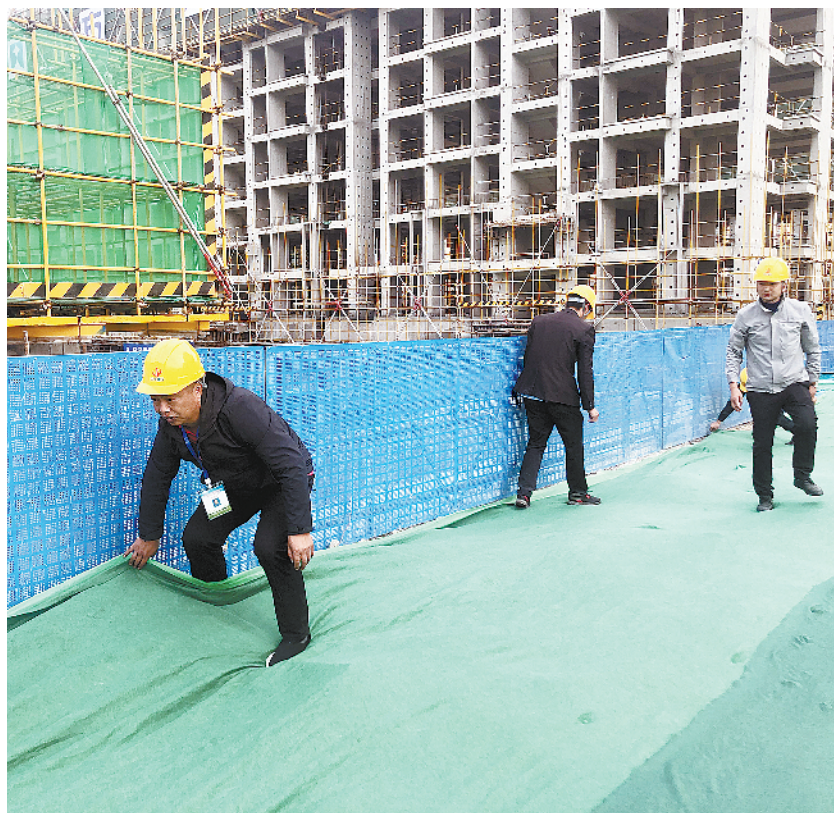
盖上土工布防尘土飞扬
