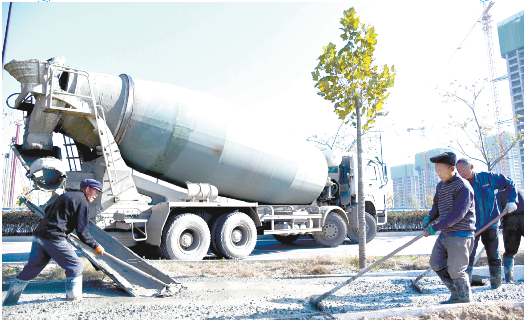
近日,市城乡一体化示范区相关市政设施建设紧锣密鼓地推进,主干道武盛大道升级改造施工正酣,确保年前完工。图为施工人员铺设人行道。 记者 梁照曾 摄
