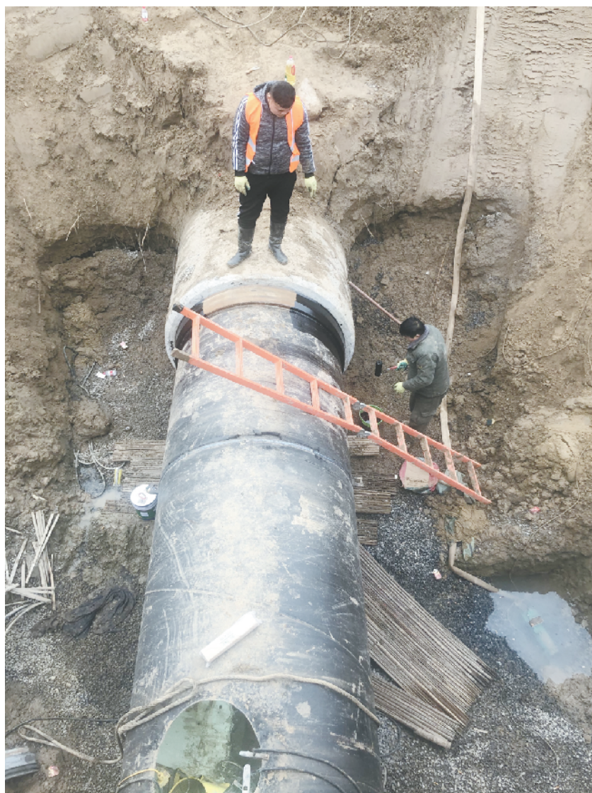
工人在施工现场忙碌
