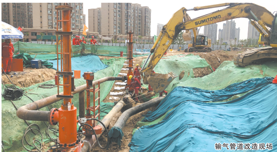
用冷切技术切割管道
