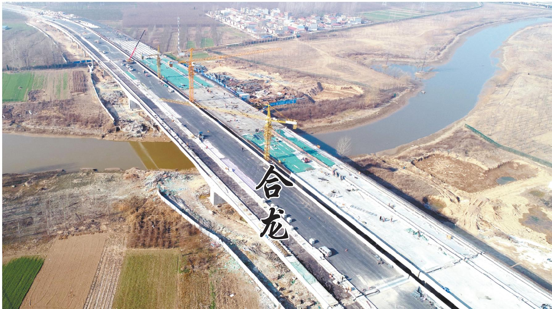
全长904.22米的新北环贾鲁河大桥作为新北环建设项目的重点节点工程,备受市民关注。目前,桥梁整体已成功合龙,左(南)半幅桥油面已铺设完毕,右(北)半幅桥油面正在紧张施工,预计本月底完工。
