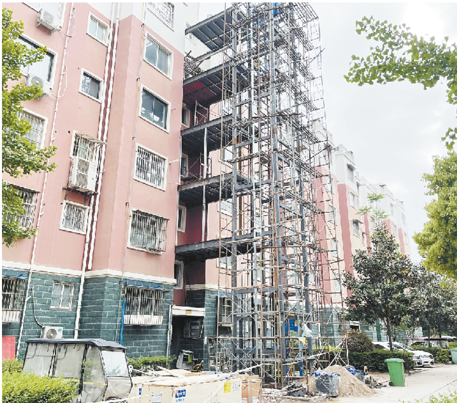
广电欣苑小区加装的电梯已装上钢结构
