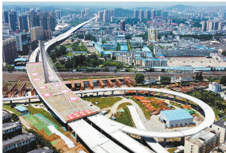
这是6月22日拍摄的成功转体后的河南信阳跨京广铁路斜拉桥（无人机照片）。
