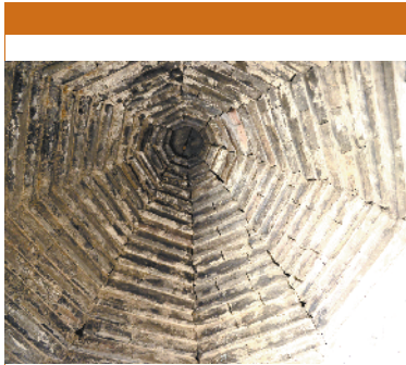
商水寿圣寺塔塔顶内部构造
