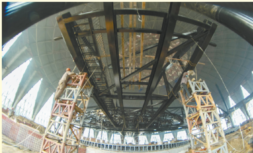
安装中的空中舞台钢架结构
