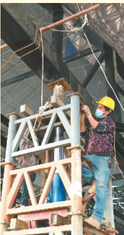
在液压提升中，工人安装支撑架
