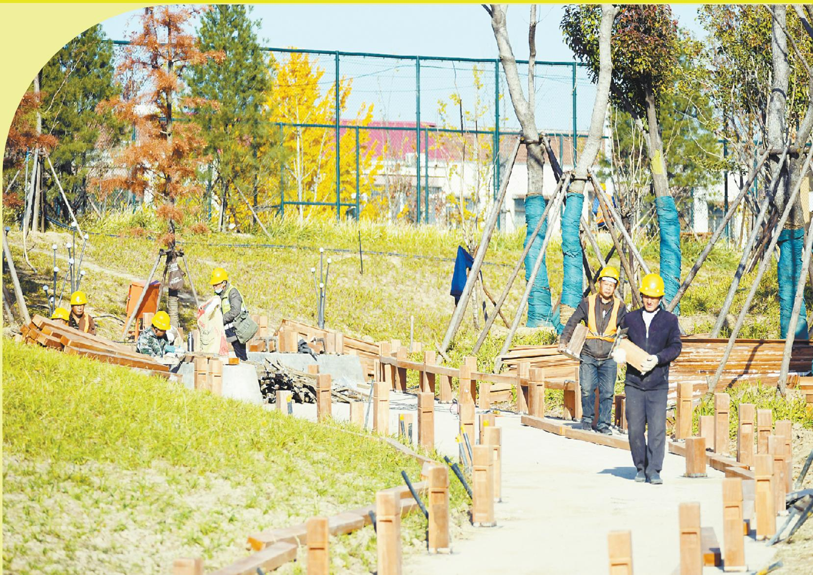
11月24日,工人在沙颍河周口大道至八一大道段生态改造工程EPC项目进行岸坡硬化、人行栈道铺设、补种绿植等工作。
