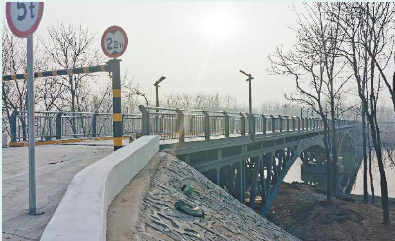
在周口市中心城区西环路西侧有一座连通周口和西华的大桥——孙咀颍河大桥，也有人称张柿园桥。它横卧在颍河之上，全长214米，该桥修建于上世纪70年代，由于时间长、桥梁老化、桥面狭窄，仅能单向通行，给两岸群众出行带来诸多不便。为解决群众的出行难题，市委、市政府把孙咀颍河大桥升级改造工程列为中心城区重点民生实事之一。
