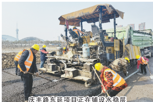
庆丰路东延项目正在铺设水稳层
