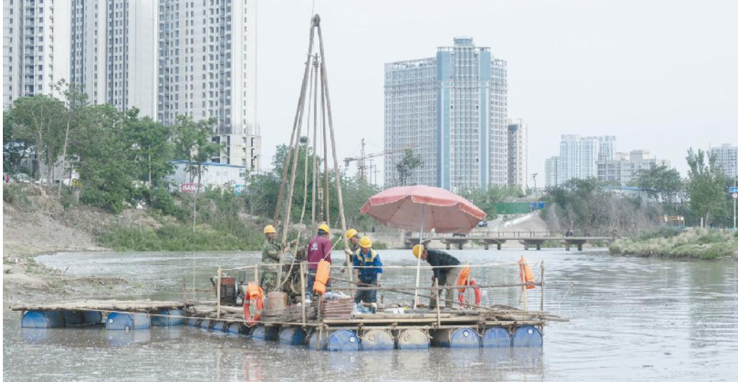
5月15日下午,施工人员在贾鲁河内开展河床地质勘探,以了解土层状况,为未来的文昌大道跨贾鲁河大桥(新二板桥)施工做准备。文昌大道跨贾鲁河大桥是我市的重点规划项目,也是文昌大道西延的重要组成部分,于近年纳入城市建设规划中。③3
