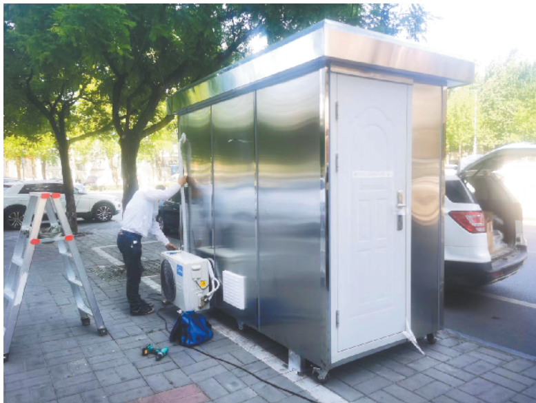
工作人员为核酸采样工作站安装空调
