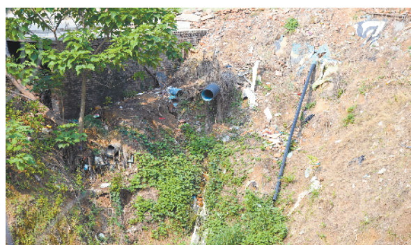
太康县老冢镇后岗村内坑塘边有陈年垃圾、生活垃圾,且存在污水直排现象
