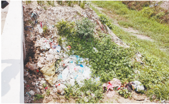
商水县大武乡东白马沟桥南侧沟坡有大量生活垃圾、废弃物,路边有散落生活垃圾
