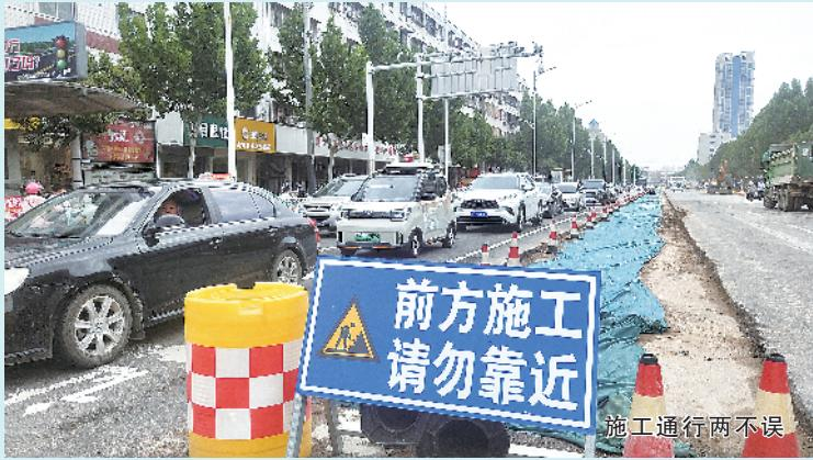
周口中心城区交通大道(龙源路至周口大道段)提升改造工程已进行月余,8月31日,在交通大道与五一路交叉口道路改造工程现场记者发现,以往道路改造都需要封闭现场或限行,而这里尽管施工如火如荼,却完全没有影响正常的交通通行,诀窍就在于采用“借一还一”半幅施工,即把原有道路一分为二,确保双向4车道正常通行。不仅如此,该道路将“海绵城市”建设理念融入道路改造,在适应环境变化和应对雨水带来的自然灾害等方面具有良好的“弹性”。
