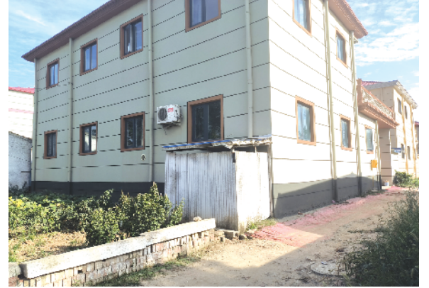
淮阳区冯塘乡岳杨庄桥西南 100 米有户外旱厕
