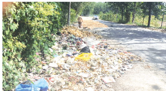
周口监狱东北角路面路沟堆积大量垃圾
