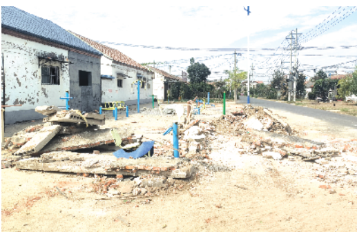
黄泛区实业集团市场街东侧路南健身区域堆积有大量建筑垃圾
