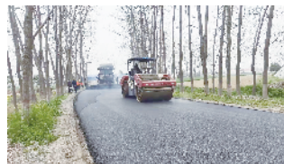
县乡公路施工现场
