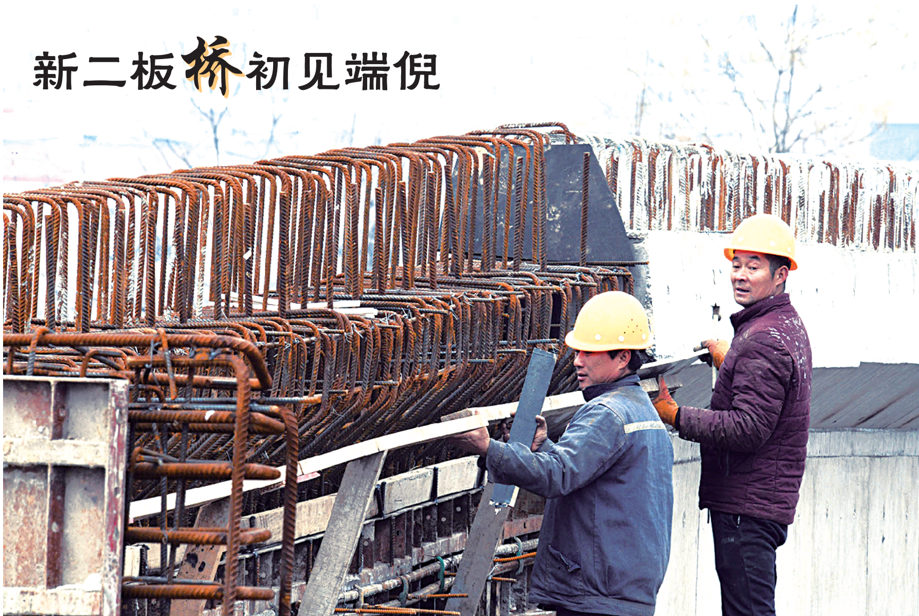
2月16日,在位于周口市中心城区的贾鲁河新二板桥建设工地上,工人们正搭建预制板,为建设桥台做准备。经过半年的施工,新二板桥桥柱浇注工程已完成过半。据了解,新二板桥项目工期为一年,是文昌大道西延的重要工程。②18 记者 梁照曾 摄
