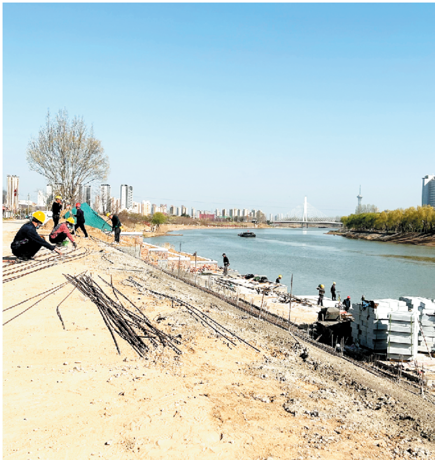
在八一大道桥向东河堤北岸，划坡为台改造工程进行中。
