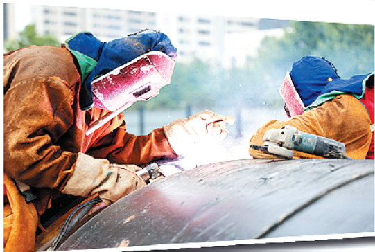
工人正在进行暖气管道焊接
