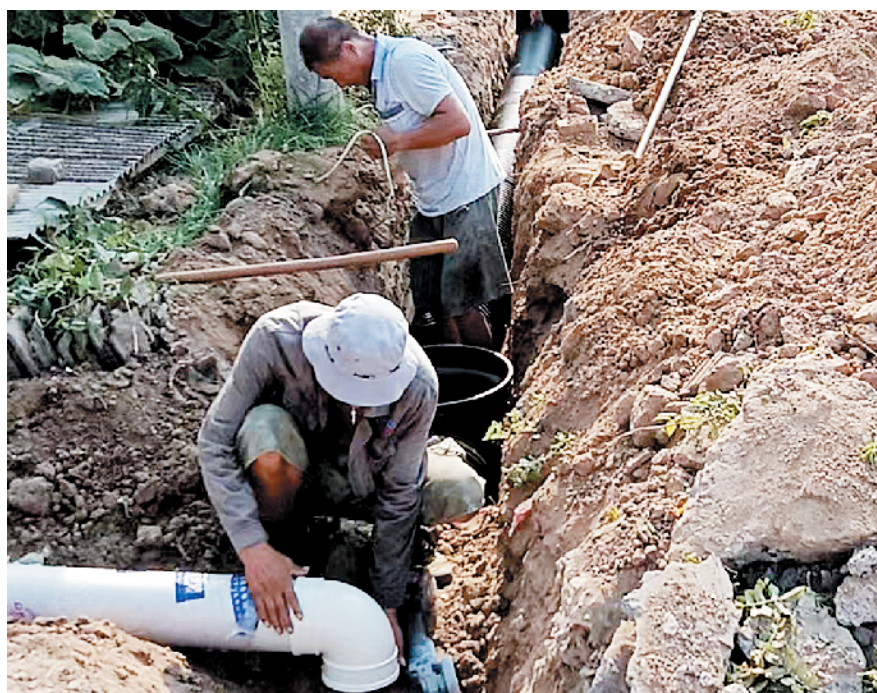
郝岗镇三义村党员干部参与下水道铺设工作
