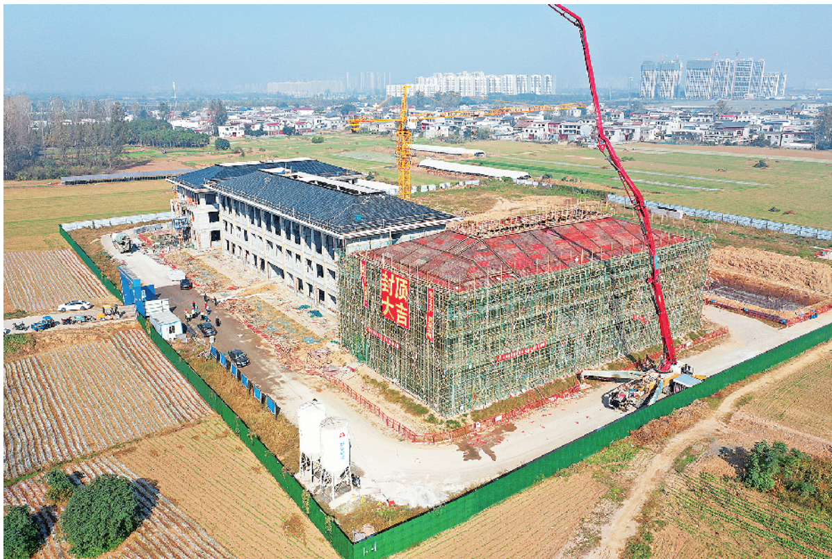
泵车正在浇筑周口服务区 2# 辅楼最后一层混凝土。
