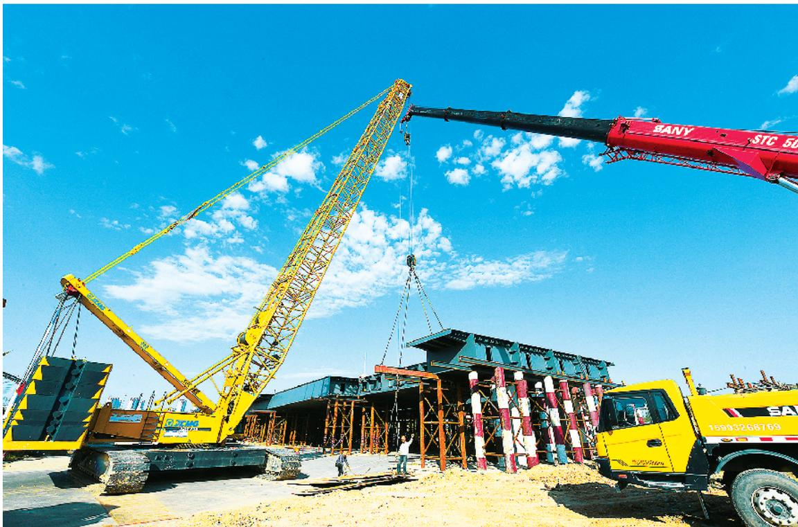
11月1日上午,在中心城区七一路跨沙颍河大桥工地上,工人在吊装该桥跨滨河南路钢结构桥体。据了解,该桥跨沙颍河南路及滨河南路的桥体采用钢结构。经过半个多月的施工,该桥跨滨河南路钢结构桥体吊装工程进度已完成约三分之二。随后,将吊装该桥跨沙颍河南路钢结构桥体。
