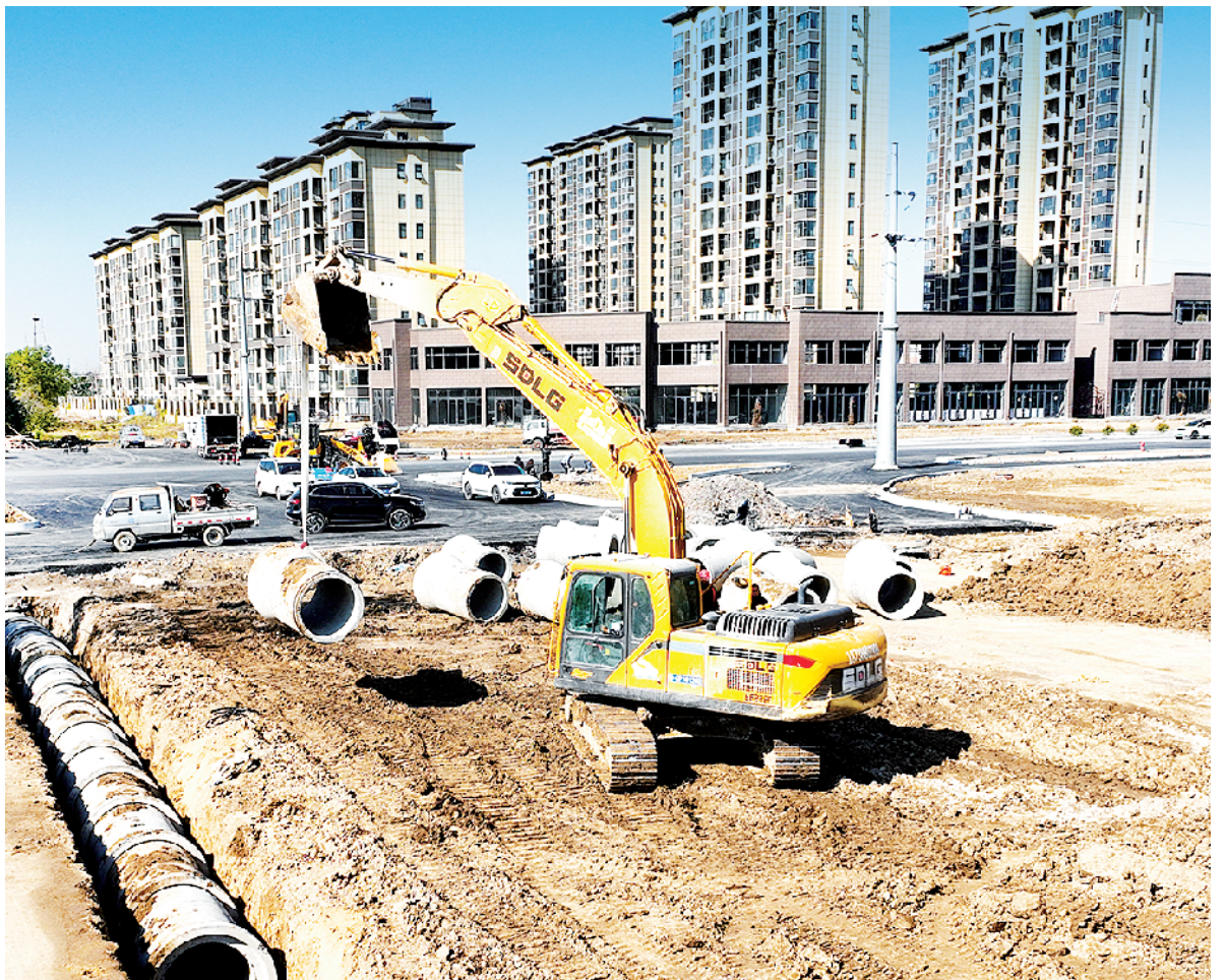
郸城县交通路西延工程施工现场。
