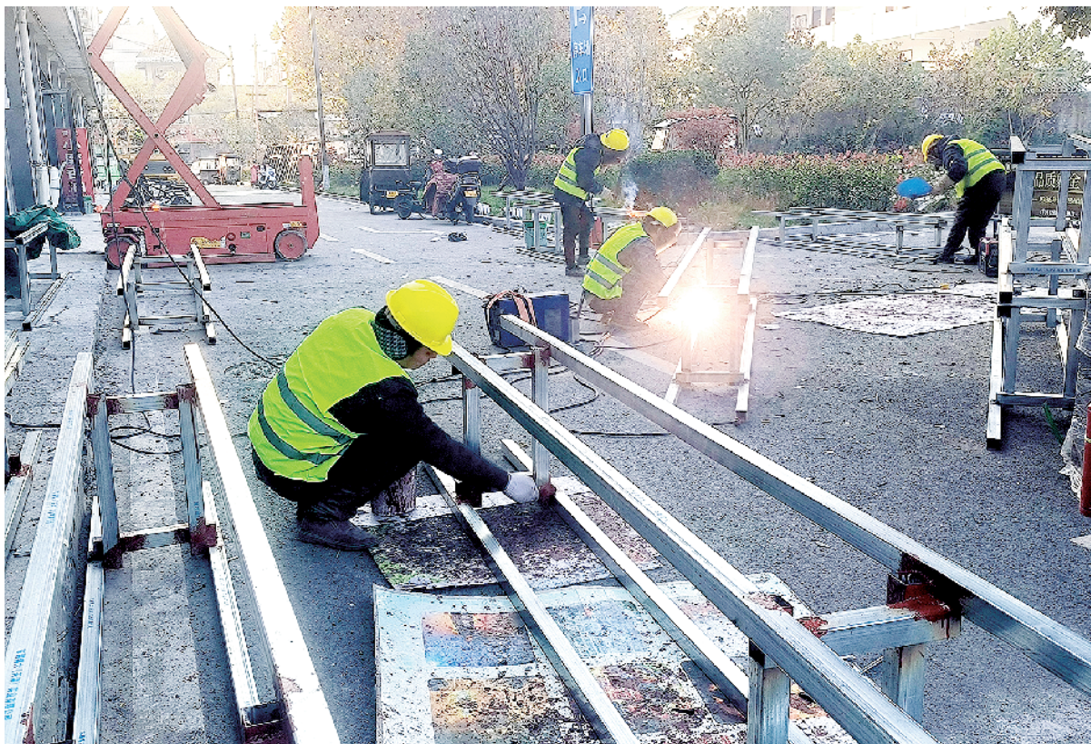
12月4日,在周口市关帝庙历史街区城市更新改造工程现场,施工人员正抢抓晴好天气时机,紧锣密鼓推进工程建设。 记者 沈湛摄
