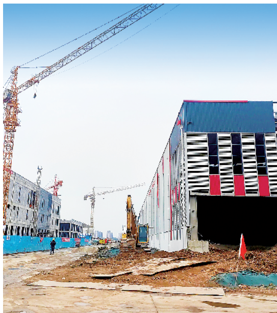
建设中的周口多式联运国际物流港。
