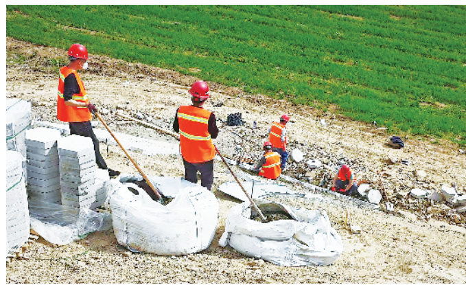
中州大道北延项目工人加紧施工。
