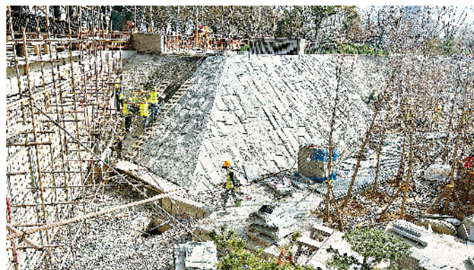
西坑公园,工人正进行石材挂贴作业。
