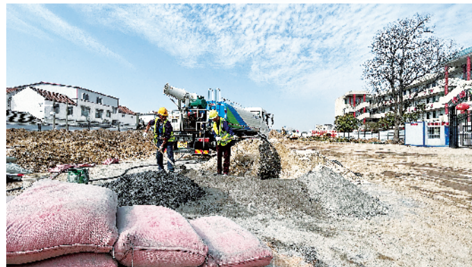
文昌大道西延工程施工现场。
