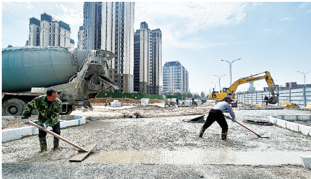
建设大道东延工程点,工人正进行人行道垫层浇筑。
