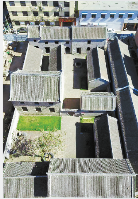
修复后的李家当铺院。
