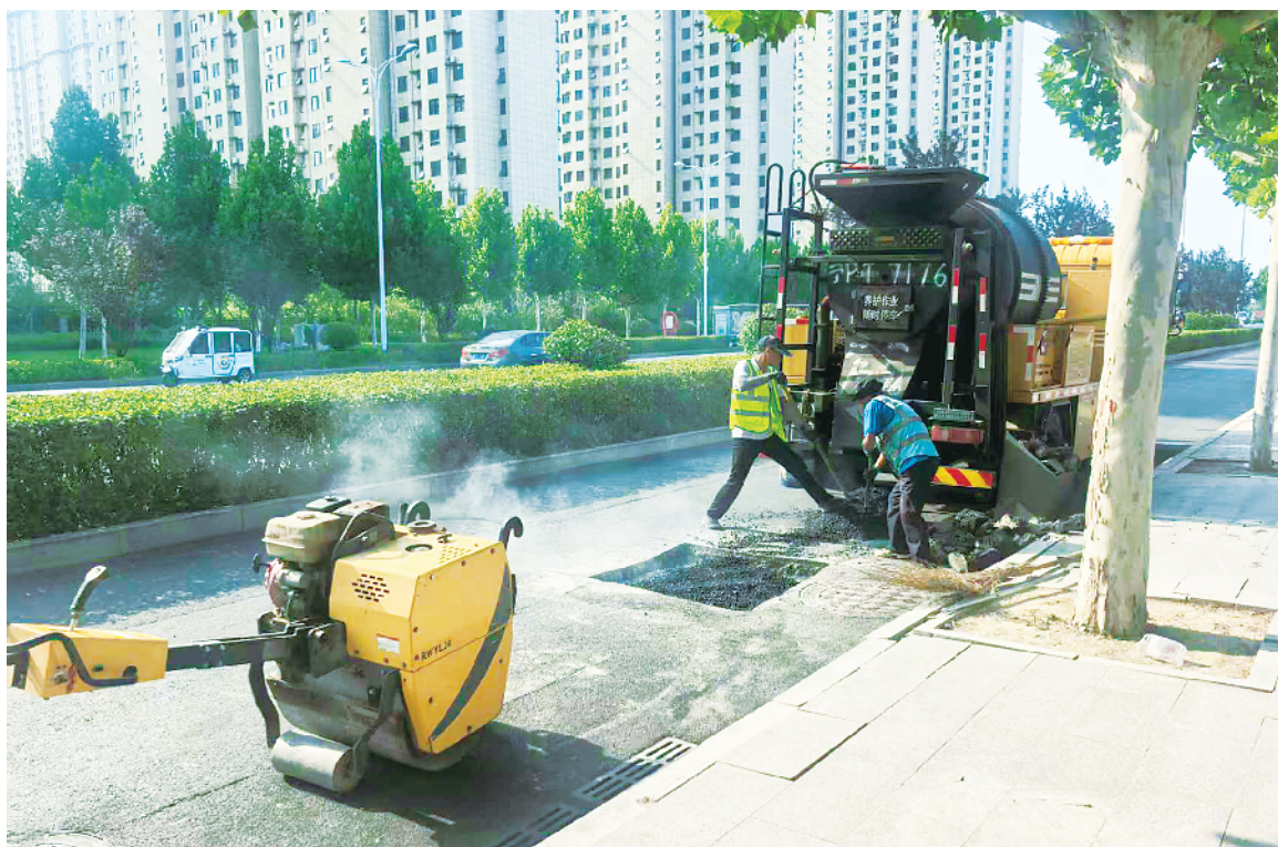
施工人员在修复凹陷处。
