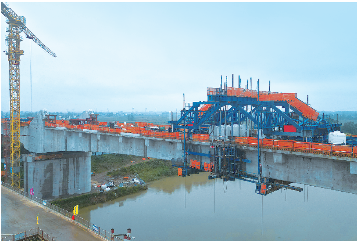
无人机拍摄的跨沙河连续梁合龙施工现场。记者 王永剑 摄
