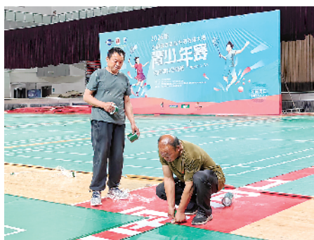
施工人员在为赛场铺设场地标识。
