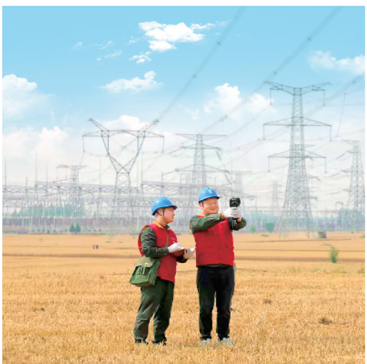
运维人员使用无人机巡查线路。
