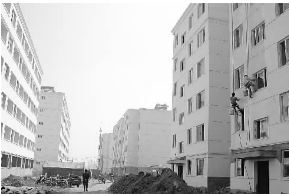
昨日,在位于川汇区八一北路的周口市保障性住房安置小区内建筑工人正在紧张施工。为进一步完善城市住房保障体系,使更多市民共享经济发展成果,市委、市政府在八一北路新建了一处保障性住房安置小区。
