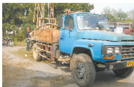
勘察分院先进的钻探设备在地质勘探
