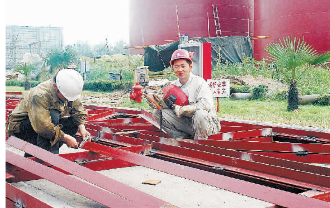
技改是企业永恒的主题,是技术创新成果产业化的主要方式,也是推进产业结构调整、转变经济增长方式和增强工业发展后劲的重要手段。我市企业不断加大技术改造力度,推动了全市工业经济的快速发展。图为我市某重点企业技改现场。(记者 沈湛 摄)
