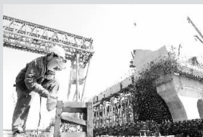
“中原第一跨”的岭南高速公路蒲山特大桥施工现场。
